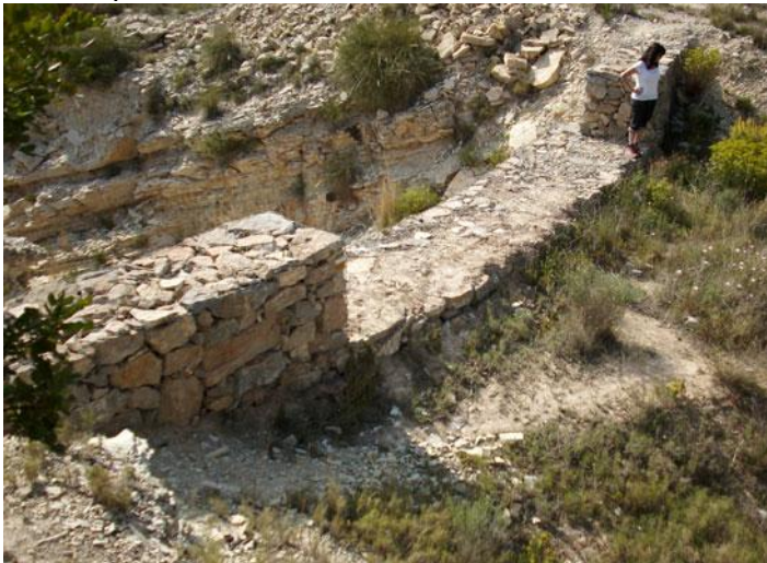
Dique de control de avenidas en barranco
