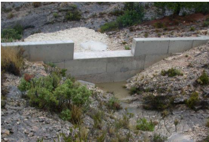
Dique de recarga
